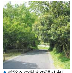
▲道路への樹木の張り出し
