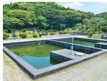
▲柳浄水場内の「ろ過池」
