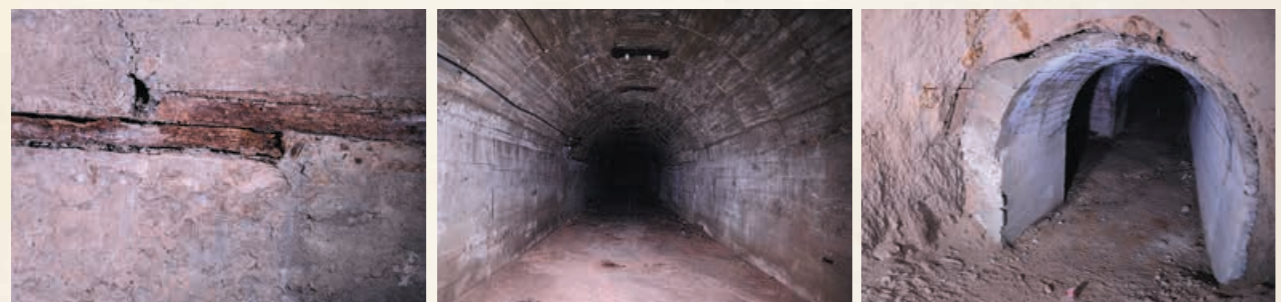
壁に釘などを刺せるように張られた参謀室跡の壁面の木レンガ 暗号室跡 作戦電話室と参謀室をつなぐ通路
