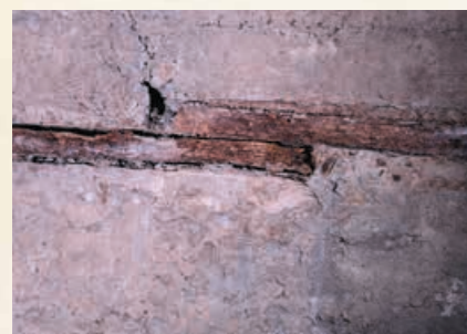
壁に釘などを刺せるように張られた参謀室跡の壁面の木レンガ
