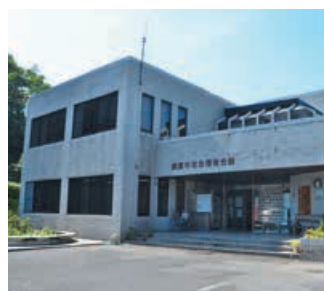
センターが置かれている 鹿屋市社会福祉会館
