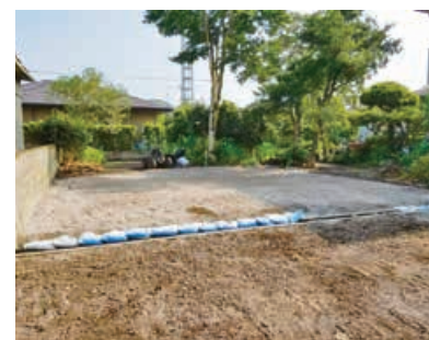
空き家（上の写真）を解体した様子
