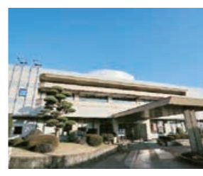
▲市役所分庁舎(寿2丁目)
