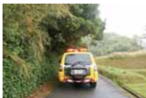
▲道路への樹木の張り出し
