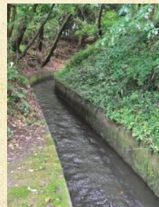
のちに為吉が実施した「始良三新田溝」事業。写真は現在の中用水路。
