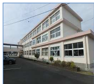
寿小外壁改修
