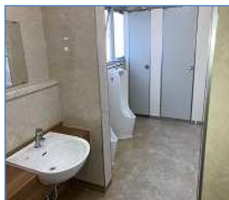
吾平小トイレ改修
