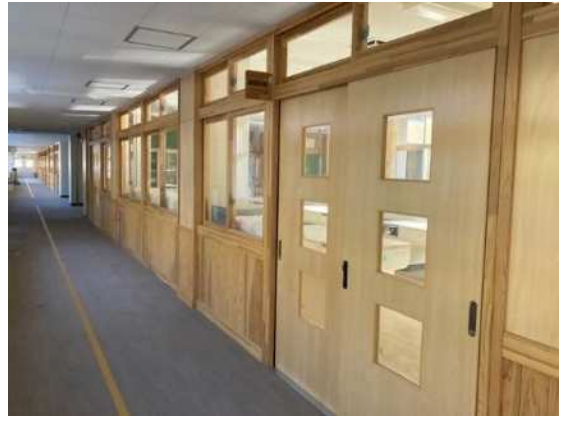
西原台小全面改修（内部）
