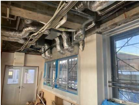
田崎中空調機器更新・照明LED化
