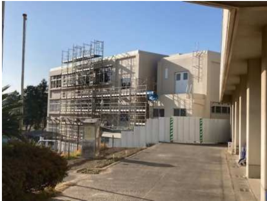
野里小全面改修（外部）
