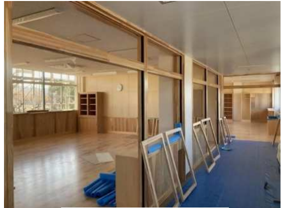
野里小全面改修（内部）
