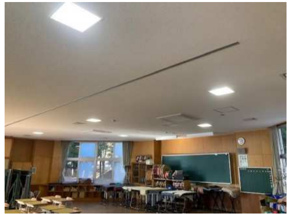
西原台小空調機器更新・照明LED化
