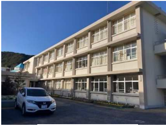
西原台小全面改修（外部）
