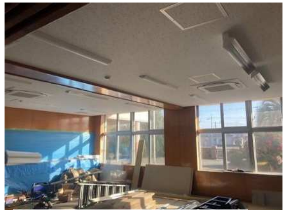
田崎中空調機器更新・照明LED化
