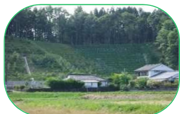
土砂崩れを防ぐ
