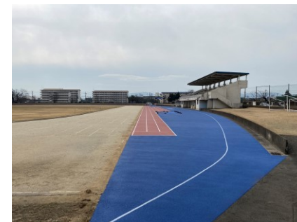
鹿屋運動公園陸上競技場 ウレタン舗装
