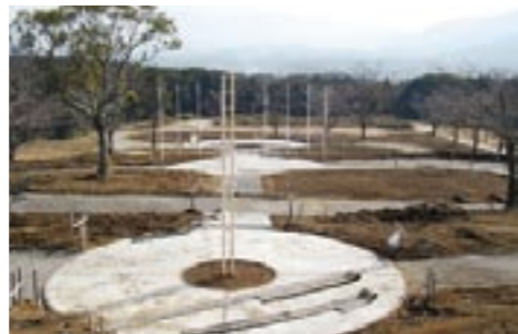
工事が進む市民ガーデン
