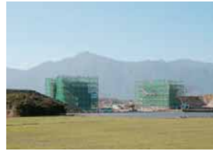
建設が進む鹿屋串良インター線
