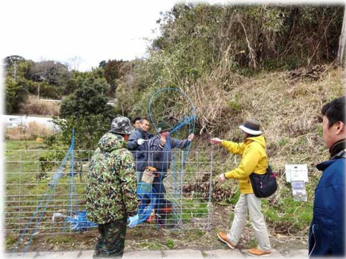
▲ 電気柵の設置
