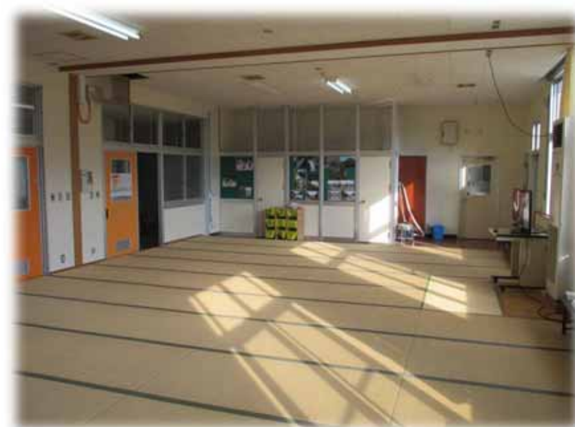
▲ 旧神野小職員室改修
