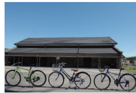
たかくま石蔵館とレンタサイクル
