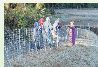
▲侵入防止柵の整備
