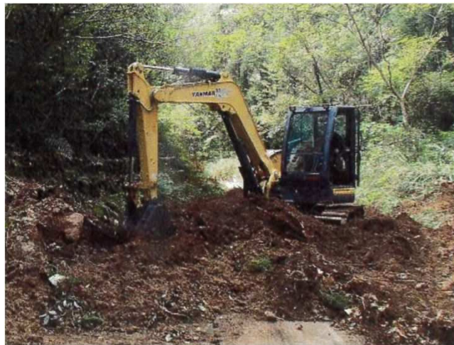
管理道路の復旧
