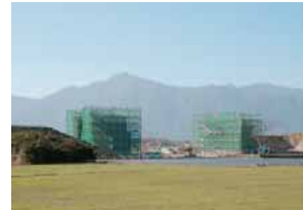
建設が進む鹿屋串良インター線
