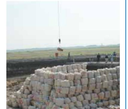
10月12日、海上自衛隊鹿屋航空基地で、不発弾の処理が行われました。この不発弾は、太平洋戦争中に米軍が使用していた250kg爆弾で、直径約40cm、長さ約130cm。陸上自衛隊の不発弾処理隊による信管(起爆装置)の除去作業は、周囲に高さ6mの土のうを積み、半径40mを立入禁止にして行われ、約2時間で作業は無事終了しました。
