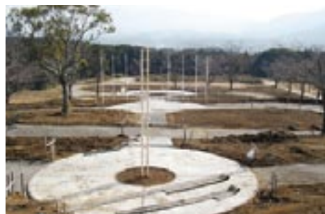
工事が進む市民ガーデン
