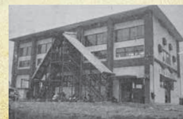
野里町にあった紅茶工場は、茶を2階の乾燥室などに運ぶための外階段が取り付けられていた。(写真は昭和37年12月発行の広報かのやより)
