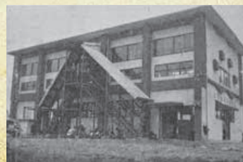
野里町にあった紅茶工場は、茶を2階の乾燥室などに運ぶための外階段が取り付けられていた。(写真は昭和37年12月発行の広報かのやより)
