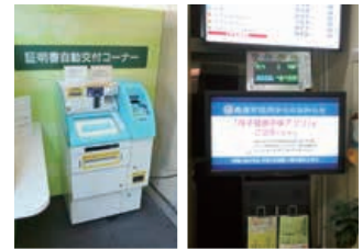
タッチパネルの案内板以外にも市役所には様々な機器が設置されています。
