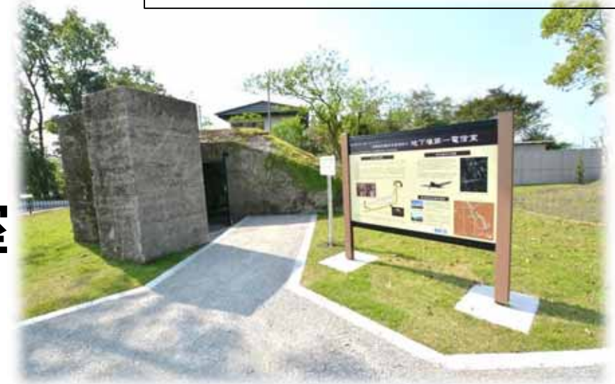
▲ 串良基地跡の 地下壕第一電信室
