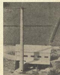
昭和38年に寿町に新設された焼却場。現在はひまわり公園になっています。
