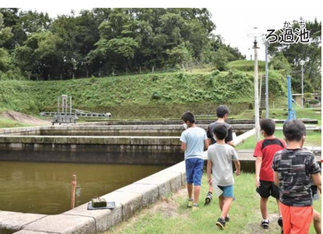
▲水を砂や砂利などの層に通して、ゴミを取り除きます。ろ過池はテニスコートより少し小さい広さで、全部で6つ設置されています。活用した砂は1か月に1回取り除きます。
