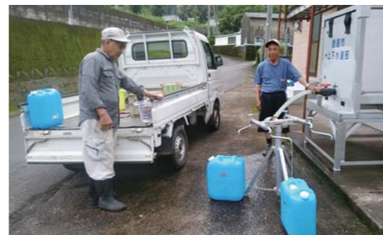
▲断水地域への組立型給水タンク設置の様子 (小野原町)
