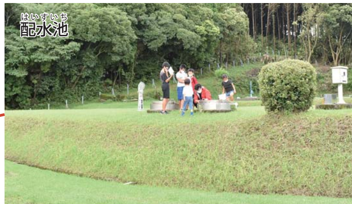
▲きれいになった水を飲める水にするため、消毒してタンクに保管します。この丘の下に約2,000ℓの水が入る大きなタンクが埋まっています。
