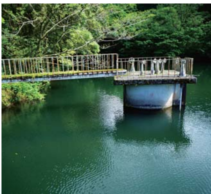
▲始良川取水口付近
