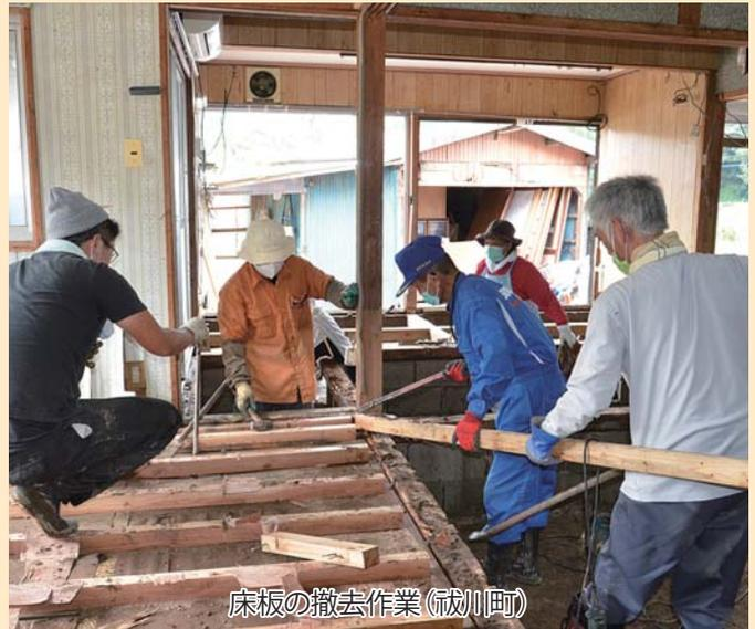
床板の撤去作業(碓川町)
