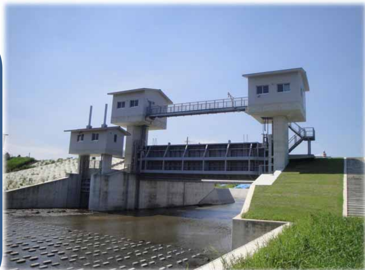
▲ 新設された新甫木水門 （H28.3月完成）
