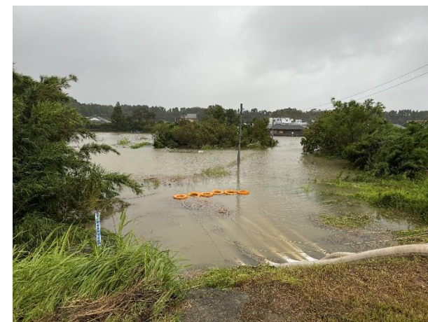
【道園樋管排水ポンプ】
