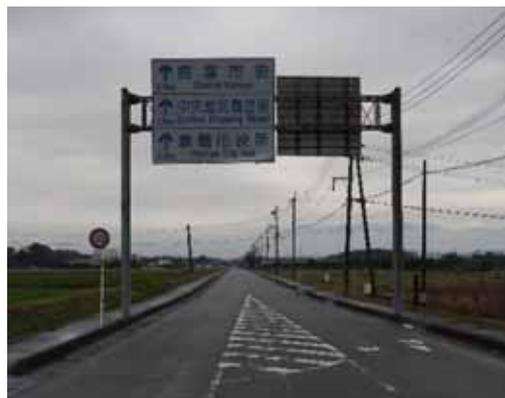
本標識は2025年現在で33年経過しており、今後、施設が老朽化することで、支柱の折れや金属片の落下などの事象が発生しないように、定期点検による確実な状態把握(早期発見)と、点検結果に基づく確実な対策(早期補修)を行う必要がある。
