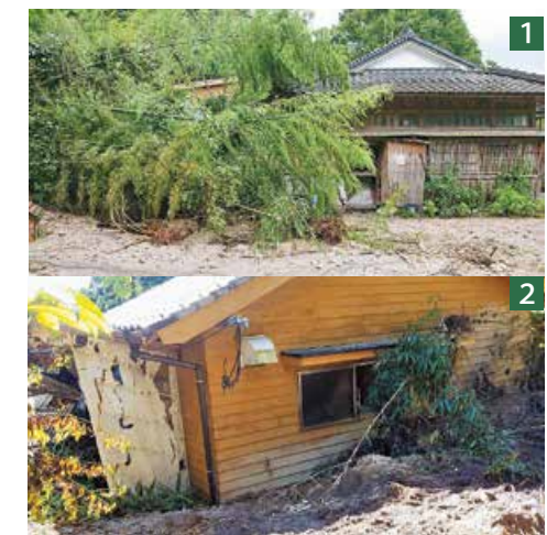
1 向かって左側の建物は土砂で完全に埋め尽くされた2 写真で見える部分は建物2階部分
