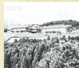
山の斜面を利用して作られた自然の家。建設中の建物は、完成間近の屋内運動場。
