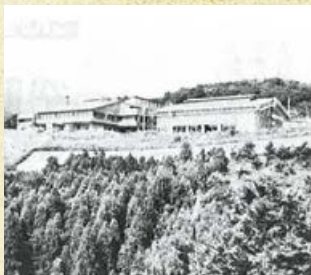
山の斜面を利用して作られた自然の家。建設中の建物は、完成間近の屋内運動場。
