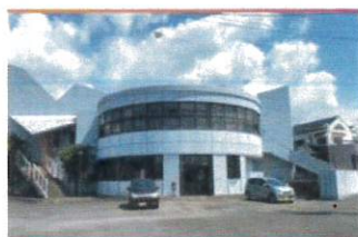
・プライムワークス建物全景
