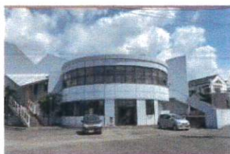
・プライムワークス建物全景
