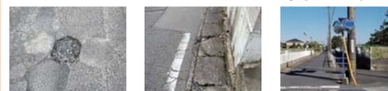
▲道路の異常箇所の例(穴ぼこ、蓋板割れ、ロードミラー倒れ)
