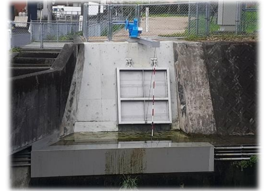
流域分散排水路(新川町)
