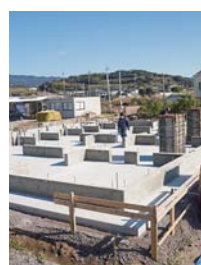
▲現在、古里町に 建設中の寮
