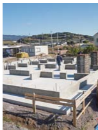
▲現在、古里町に建設中の寮
