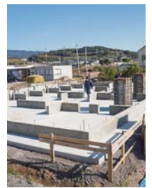
▲現在、古里町に建設中の寮
