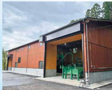
▲上高隈町に竣工されたおが粉製造施設
