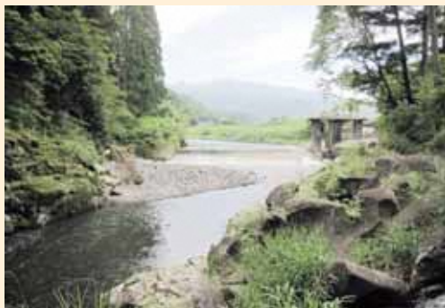
谷田発電所遠景
