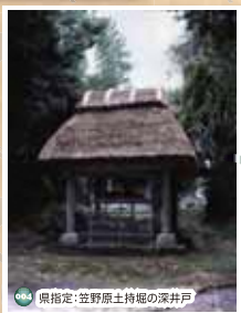
県指定「笠野原土持堀の深井戸」 笠野原台地はシルス土壌のため飲み水や農業用水に困っていた。そこで人々は井戸を掘って生活用水に役立てた。この深井戸は64mと深く、牛にロープを引かせ、つるべで水をくんでいた。
