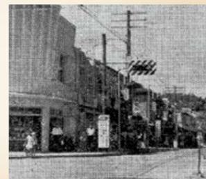
▲導入当時の写真。灯火器を目立たせるために縞模様の背面版が取り付けられている
