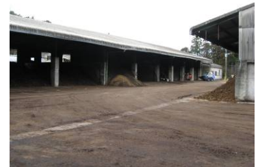
JA肝付吾平町堆肥センター
